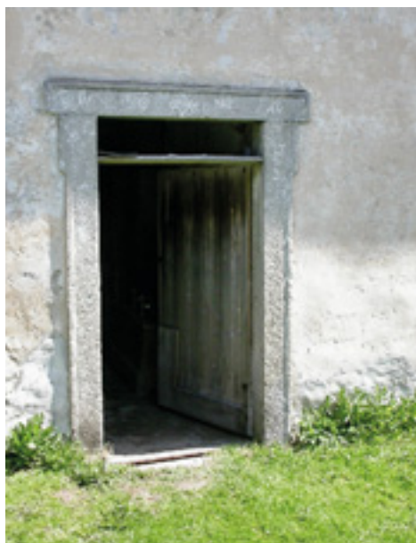
Sekundárně použité kamenné ostění hlavního vchodu je poslední dochovanou částí synagogy. Foto V. F. Chvátal.
