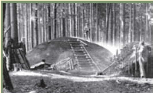
Uhlíř Schwarzmacher Harl z Brandu, který pracoval ve službě u Kolowratů na Dianabergu (dnes Diana). Milíř o cca 60 m 3 . Foceno v srpnu 1929 mezi Hraníčkami (Reichenthal) a Žebříčským Žďárem (Petlarnbrand) poblíž lokality nazývané „Roten Kreuzes“. Vpravo od milíře je uhlířská chatka. Tento milíř hořel cca 3 týdny. Foto: archiv Karla Bauera z Altenstadtu.
