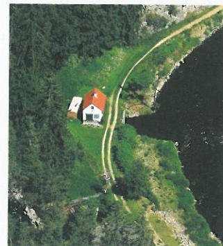
Funkční vodní elektrárna pod Dívčím Kamenem, využívající rozdíl hladin mezi Křemžským potokem a Vltavou.
